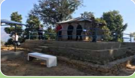
थानीथान हरियाली उद्यान निर्माण अजिरकोट ५
