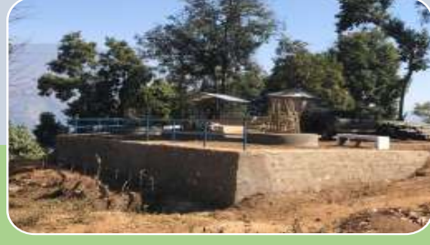
थानीथान हरियाली उद्यान निर्माण अजिरकोट ५
